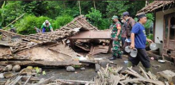
Foto: Bangunan Roboh | Kokap, Kulon Progo | 10-03-22 | BPBD Kab. Kulon Progo
