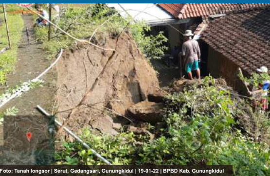
Foto: Tanah longsor | Serut, Gedangsari, Gunungkidul | 19-01-22 | BPBD Kab. Gunungkidul
