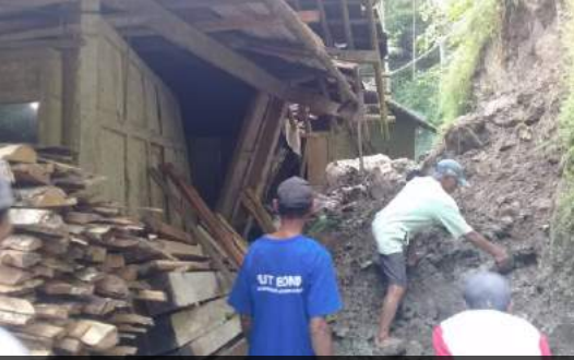
Foto: Longsor menimpa rumah warga | Girimulyo, Kulon Progo | 23-05-22 | BPBD Kab. Kulon Progo
