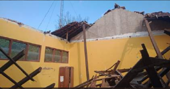
Foto: Atap bangunan sekolah roboh | Samigaluh, Kulonprogo | 03-05-22 | BPBD Kab. Kulonprogo
