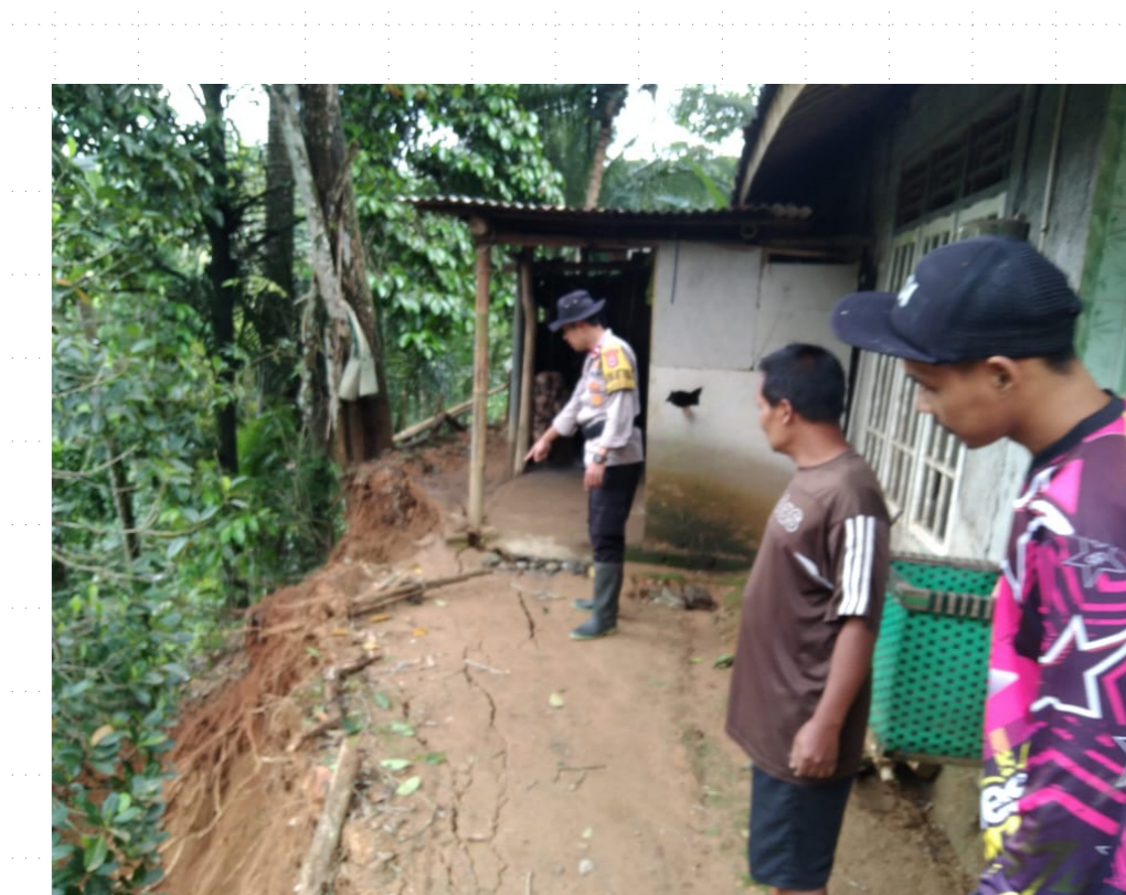
Tanah Longsor | 01-12-22 | Kokap Kab. Kulon Progo F. Babinkamtibmas Hargotirto Kab. Kulon Progo
