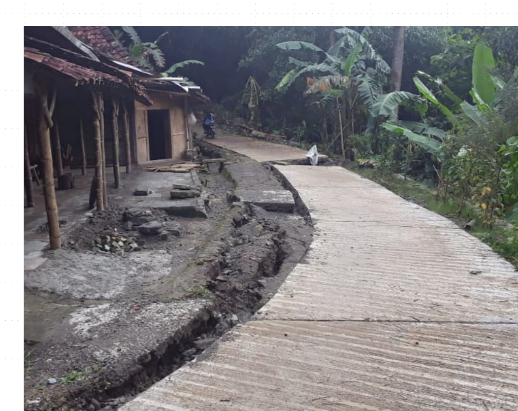
Tanah Longsor | 20-12-22 | Gedangsari Kab. Gunungkidul F. TRC BPBD DIY
