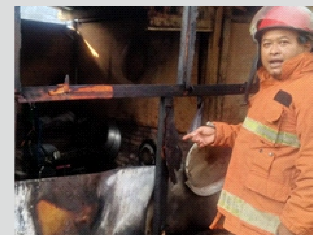
Kebakaran | 26-06-24 | Wates Kab. Kulon Progo F. Damkar Kab. Kulon Progo
