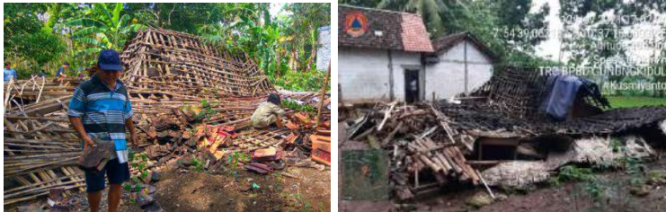
Gambar 119. Bangunan Roboh di Kabupaten Gunungkidul
