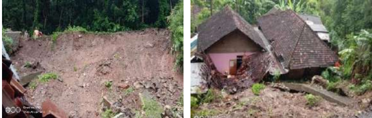
Gambar 41. Foto Dokumentasi Tanah Longsor Bantul
