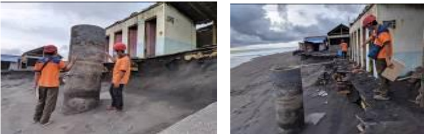
Gambar 54. Dampak Kejadian Abrasi di Kabupaten Kulon Progo.
