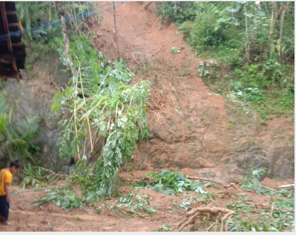
Tanah Longsor | 12-04-25 | Kokap, Kab. Kulon Progo F. Relawan Kab. Kulon Progo
