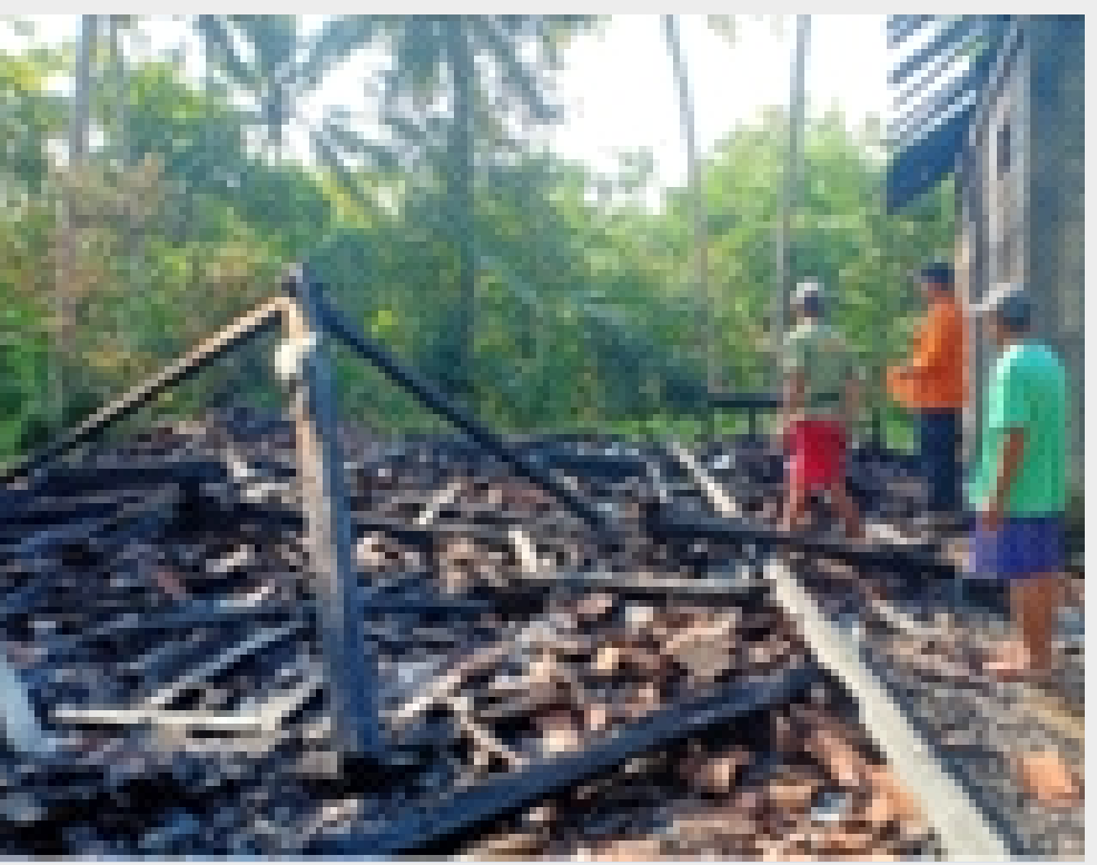
Kebakaran | 17-08-25 | Pengasih, Kab. Kulon Progo F. TRC BPBD Kab. Kulon Progo
