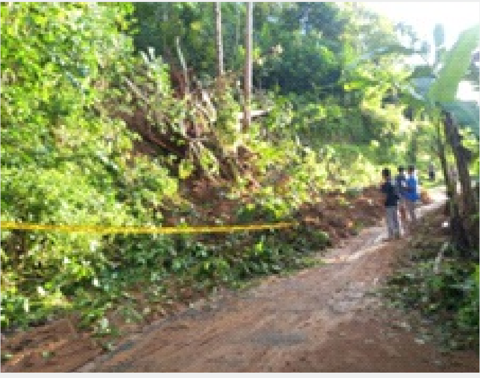
Tanah Longsor | 25-02-24 | Samigaluh, Kab. Kulon Progo F. Relawan Kab. Kulon Progo
