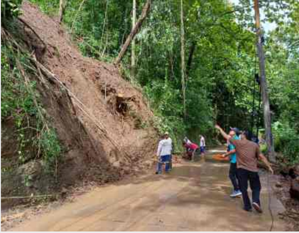
Tanah Longsor | 13-02-26 | Pengasih, Kab. Kulon Progo F. BPBD Kab. Kulon Progo
