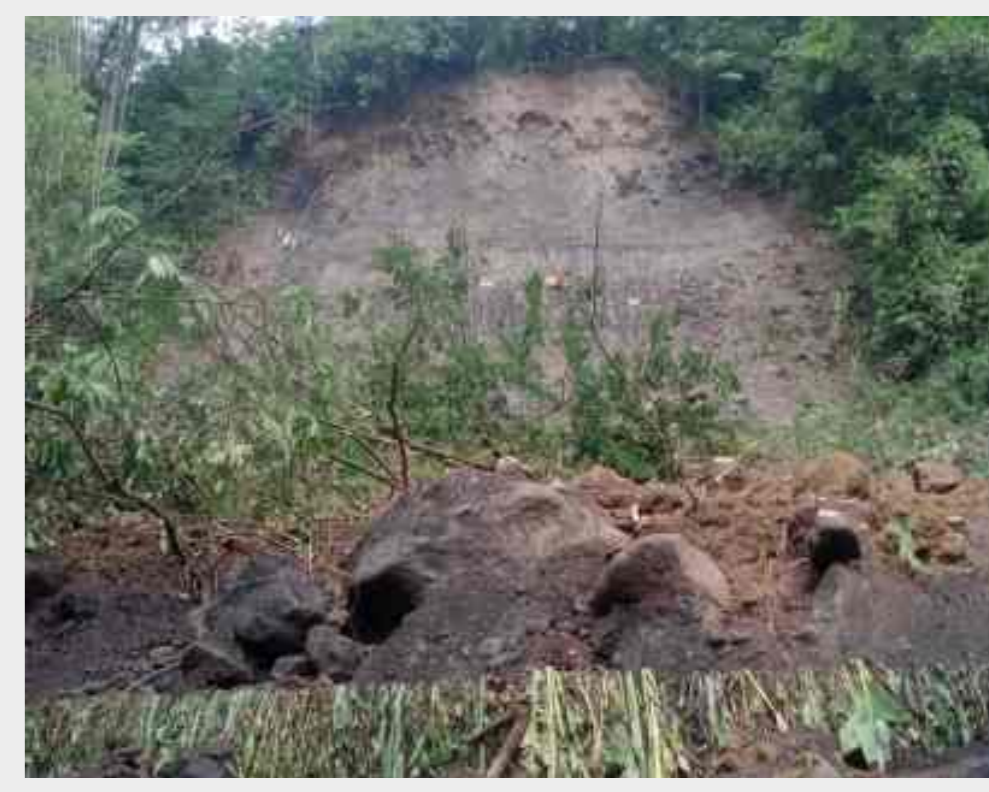
Talud Longsor | 14-04-26 | K. TNGM S. Krasak, Sleman F. TRC BPBD Kab. Sleman
