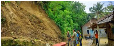
Assesment ke Kedungrejo, Wonolelo, Pleret terkait permohonan bantuan penanganan material potensi longsor susulan (08/01)
